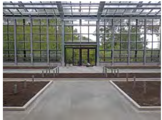
図10 広くなった通路.
