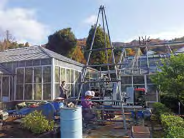
図7 ボーリング調査の様子.
