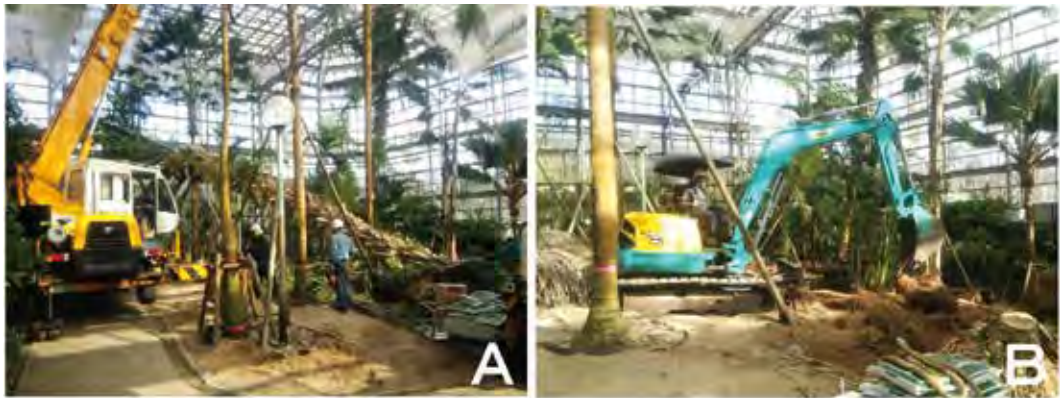
図8 不用大型植物の伐倒・除根作業。A：天井に届いたヤシの伐倒作業。B：伐倒したヤシの除根作業。
